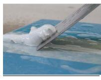
« Couper » un joint consiste à éliminer, après pulvérisation au **ZWALUW LAST 1**, l'excédent de mastic à l'aide d'une spatule à joint, d'un couteau de peintre, d'une cuiller, d'un bout de tuyau ou du fond d'une cartouche vidée.
